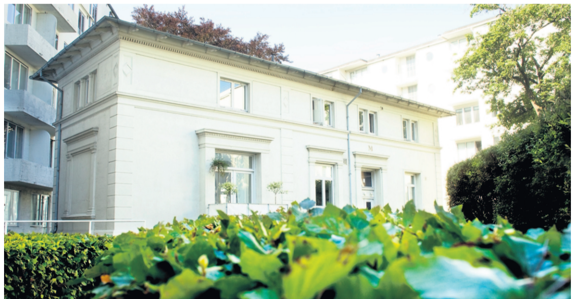
På grunden lå oprindeligt to villaer, som bygherren valgte at lade stå ved simpelthen at bygge rundt omkring dem. Tidligere blev de benyttet til selskabslokaler og pensionat, i dag er de solgt fra som ejerlejligheder.
